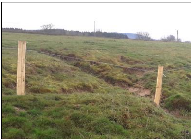
Figure 6. Exemple clôture électrique 1 fil – travaux SMBVAS 2021
