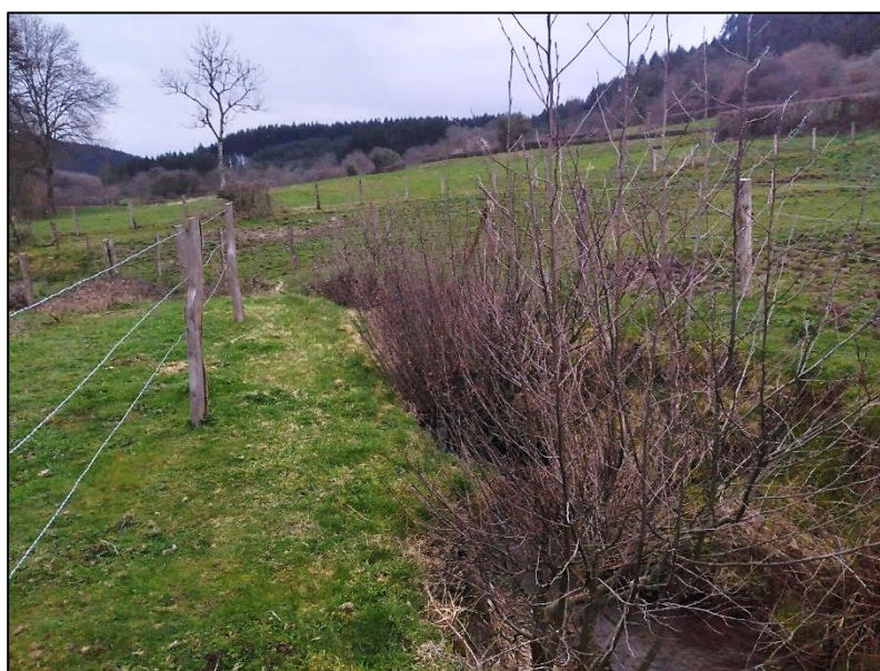
Figure 7. Exemple clôture barbelée 3 fils – travaux SMBVAS 2022
